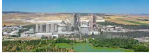
Çimsa Eskişehir Fabrikası Çimsa Eskişehir Plant
